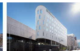
ホテル コメント 横浜関内 (神奈川県横浜市)
