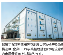
物流倉庫の免震化
