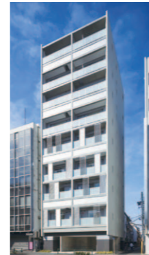
免震賃貸マンション
