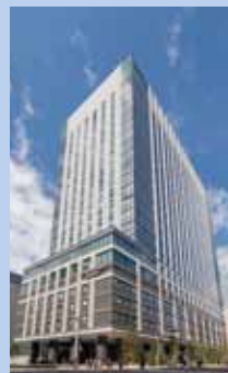
京橋トラストタワー
