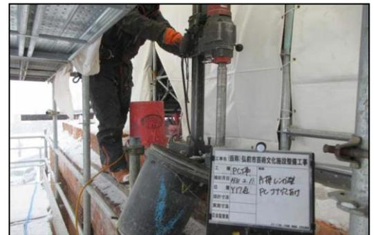
美術館棟の煉瓦壁にPC鋼棒を挿入し、補強。煉瓦壁を一体とすることで倒壊を防ぐ。
