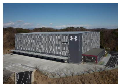
▲大規模物流倉庫。100基以上の免震装置を使用
