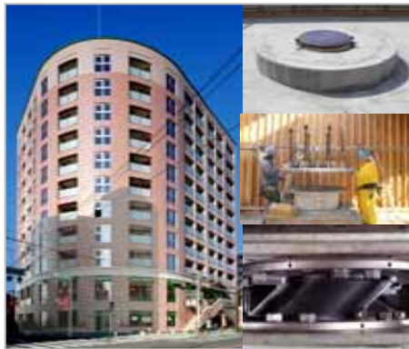
免震賃貸マンション
