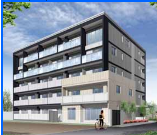
(施工場所) 府中市宮西町4 (竣工) 2007.3.23 (工種・規模) RC(免震工法)・5F
