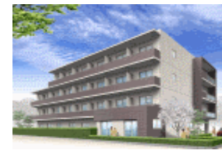
(仮称)多機能施設 きらら北栄
