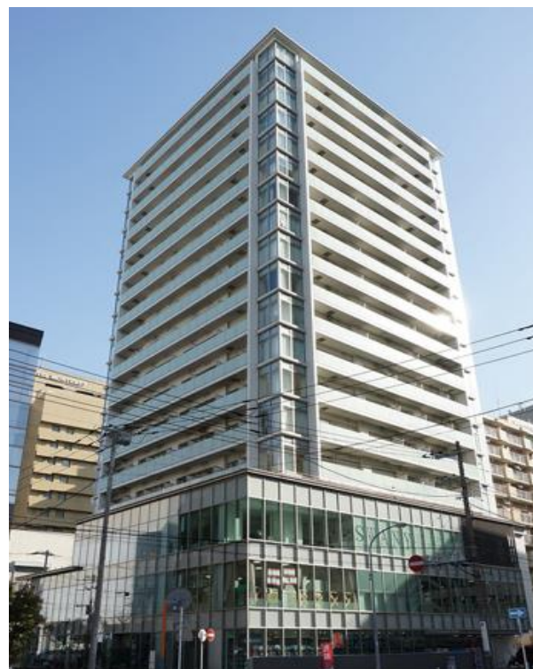
プロシード山下公園ザ・タワー
