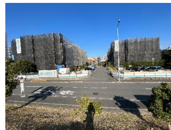
工事進捗状況
