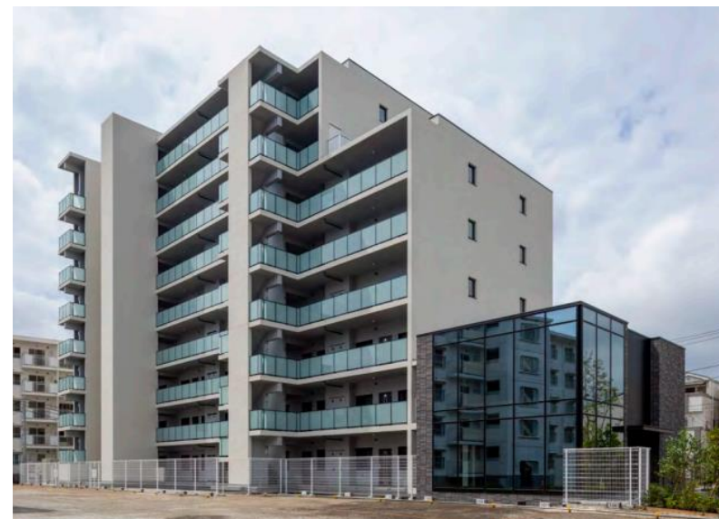
■9階建【免震RC造】賃貸住宅 3LDK-50戸 (東京都足立区) 2021年8月竣工
