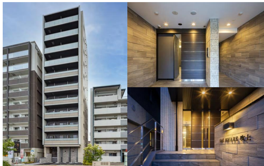
■11階建【RC造】賃貸住宅 1K-18戸、1LDK-8戸 (愛知県名古屋市) 2021年7月竣工
