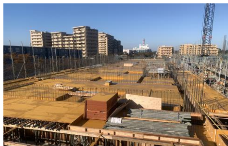
▶10月末時点工事進捗（3階部分施工中）
