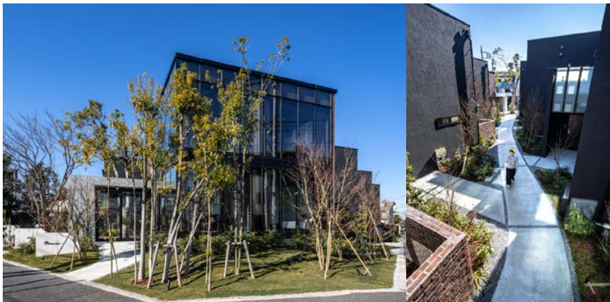
■2階建【2×4造】賃貸住宅 2LDK-4戸、3LDK-4戸 (東京都江戸川区) 2020年1月竣工 ～敷地と建物をオートロックゲートで囲み高いセキュリティを保ち、住人同士の自然なコミュニケーションを創造する～
