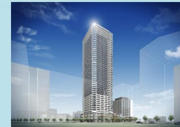
札幌北8西1地区再開発事業 北海道・札幌市 ホテル・店舗 2023年6月竣工予定
