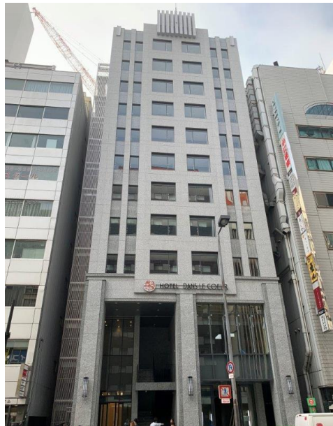
■ 地下1階地上11階建【鉄骨造】 ホテル 客室144室 (大阪府大阪市) 2019年11月竣工
