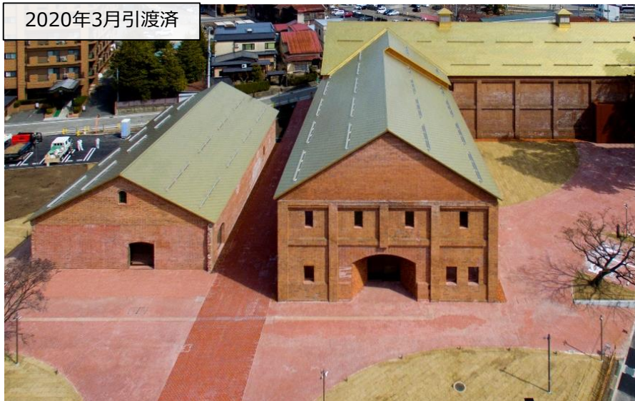
外観 (左/店舗・カフェ 右/美術館棟)
