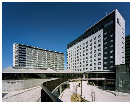
(左) 集合住宅棟 (右) ホテル・商業棟
