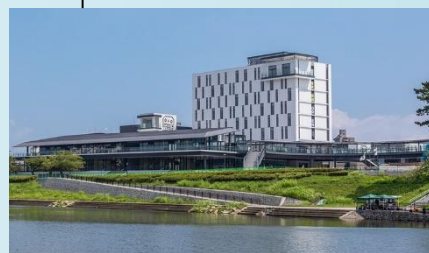
東岡崎駅周辺地区整備北東街区有効活用事業 愛知県・岡崎市 複合施設「OTO RIVERSIDE TERRACE」 北店舗棟・ホテル棟・南店舗棟・駐車場棟 2019年11月2日開業
