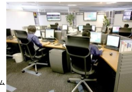
ビルコムセンター
