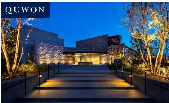
QUWON新浦安（エントランス）
