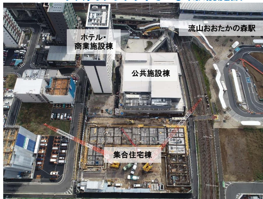
現場空撮写真 平成30年11月撮影
