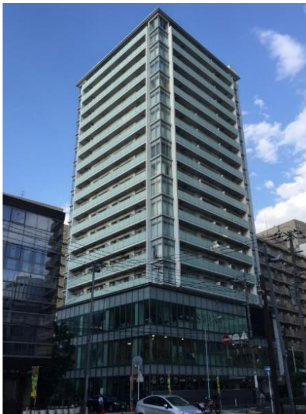
プロシード山下公園 ザ・タワー
