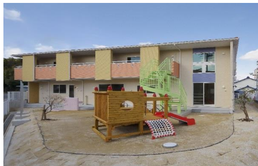
保育施設(木造枠組壁工法)
