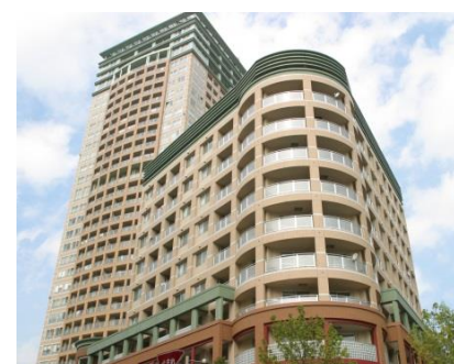
オーバルコート大崎ビュープラザ
