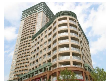
オーバルコート大崎ビュープラザ
