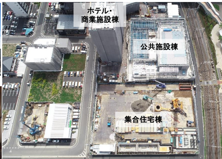
現場空撮写真 平成30年4月16日撮影
