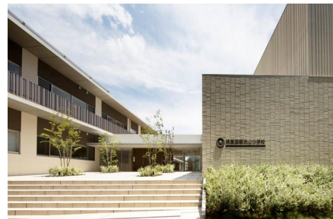
暁星国際流山小学校 (2016年4月竣工)
