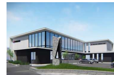
金融機関支店新築工事 (BIM活用)
