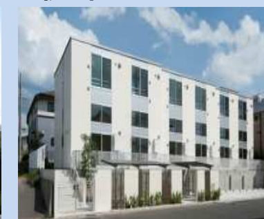
H28年9月竣工
