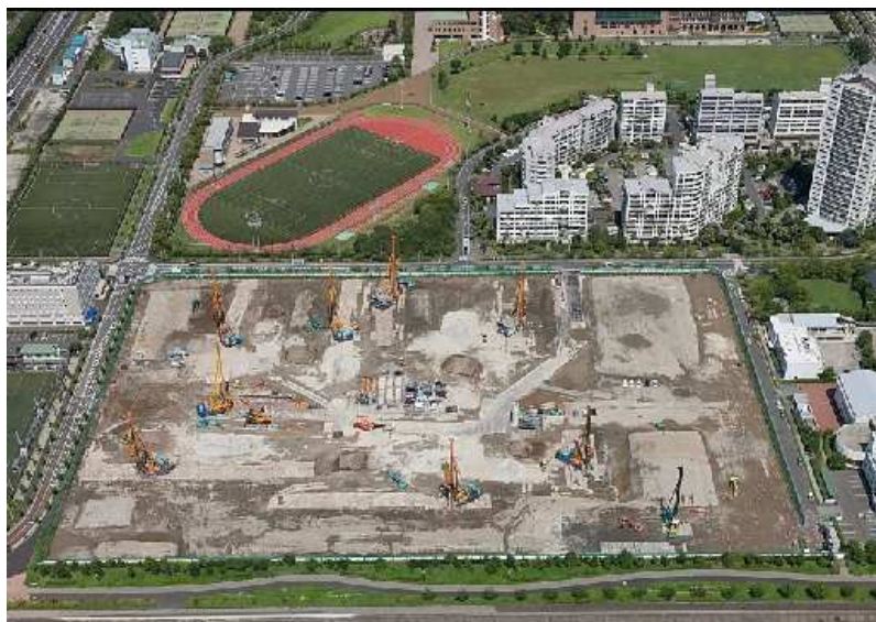
現地:地盤改良杭工事
