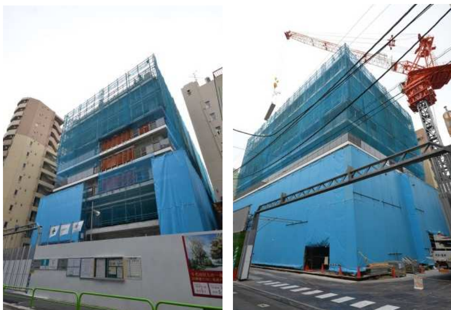
現地: 工事の様子 (11月8日時点)
