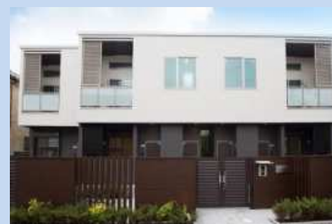
H28年9月竣工
