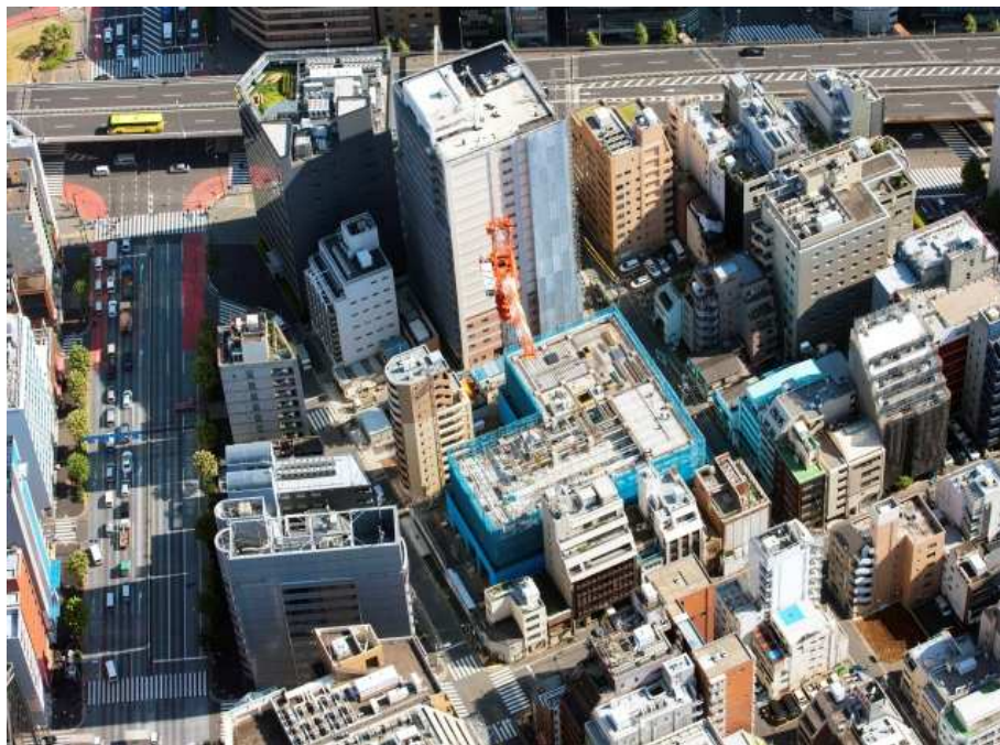
現地: 工事の様子 (空撮)
