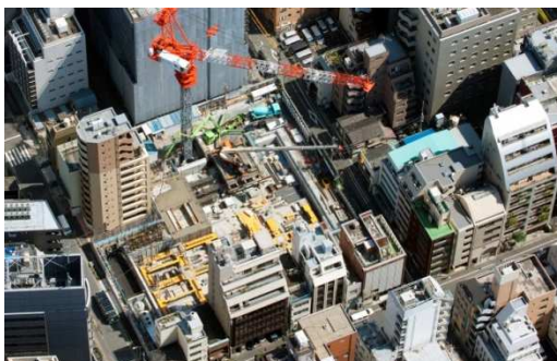
現地:工事の様子
