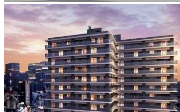
アルファグランデ千桜タワー（北東側）
