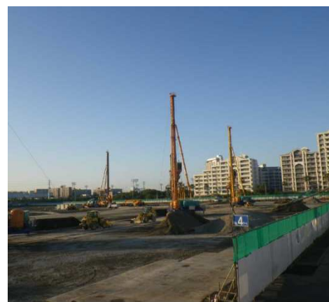
現地:地盤改良杭工事
