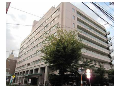
永寿総合病院(施設管理)
