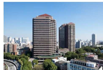
御殿山トラストシティ(施設管理)
