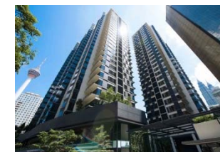
クアラルンプール物件 (コンドミニアム)
