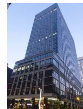
京橋トラストタワー (施設管理)
