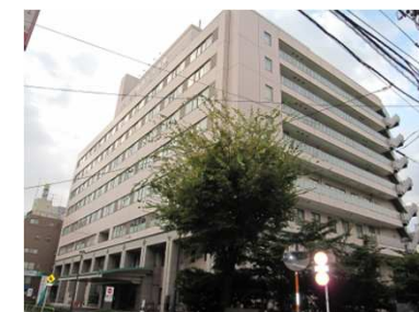
永寿総合病院 (施設管理)
