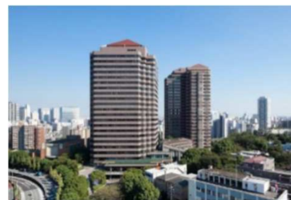
御殿山トラストシティ (施設管理)
