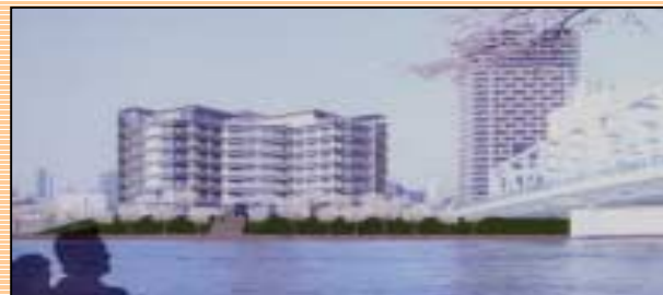
中央区PFI事業(痴呆性高齢者グループホーム等の整備・運営事業)着工
