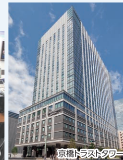
京橋トラストタワー
