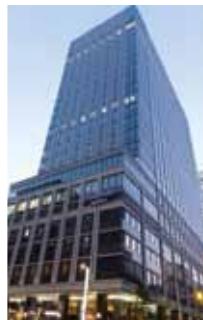
京橋トラストタワー (延床面積:約52,400㎡ 地上21階・地下3階建)
